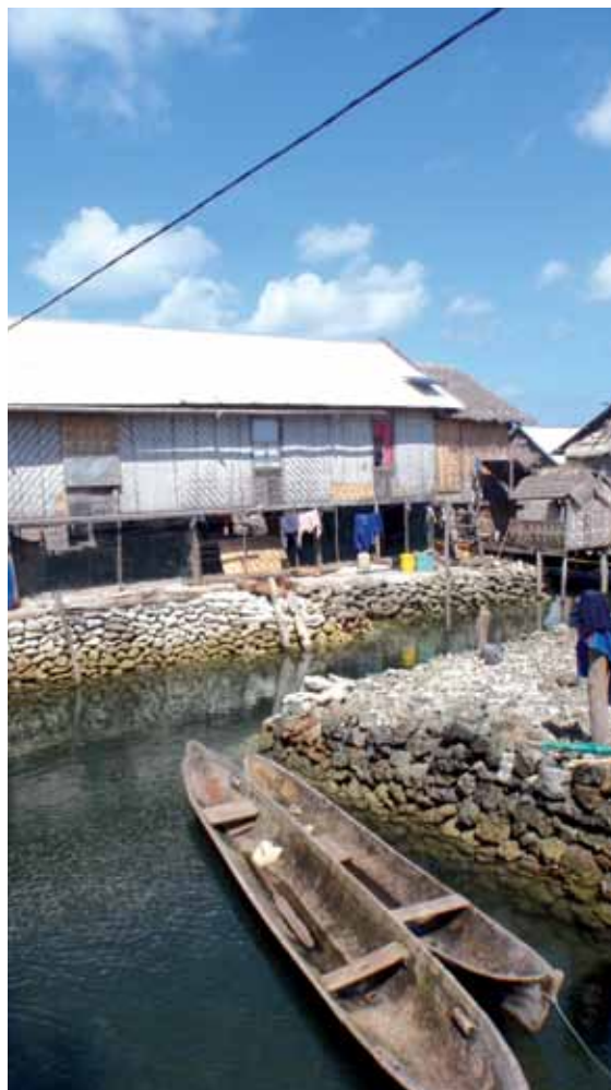
Un village en Indonésie construit sur des digues réalisées avec des squelettes de coraux.
